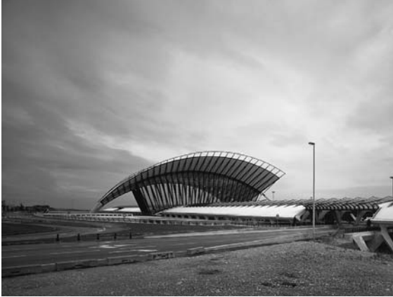
Abb. 2: Santiago Calatrava, TGV-Bahnhof des Flughafens Lyon-Satolas, 1989–1994
