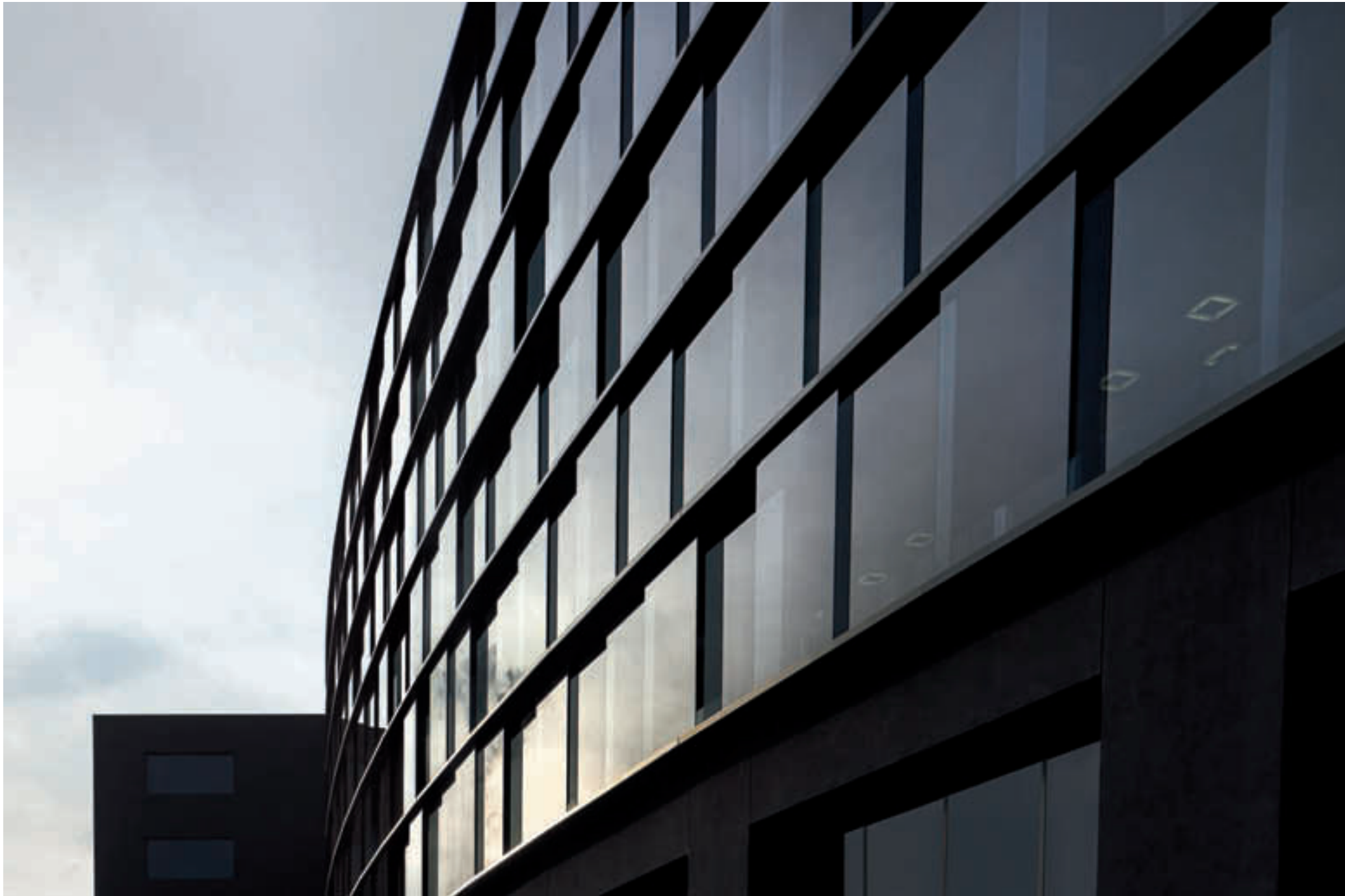
23.04.2012 Terminalerweiterung Check-in 3 Luftseite | Terminal extension Check-in 3 airside
